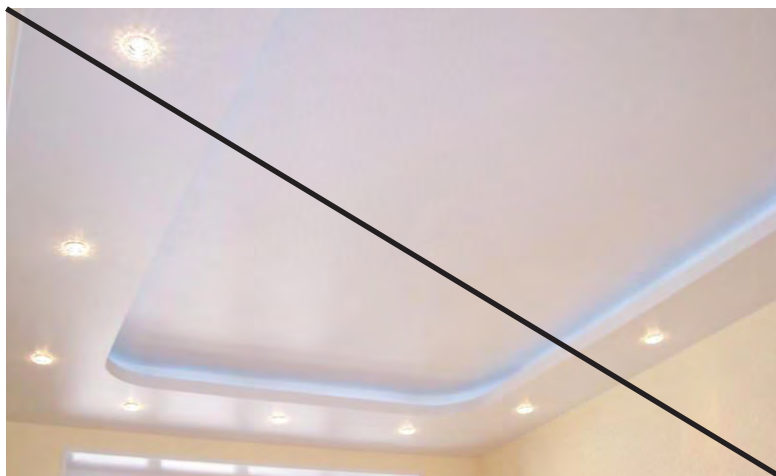
Плохо Многоуровневые гипсокартонные конструкции
